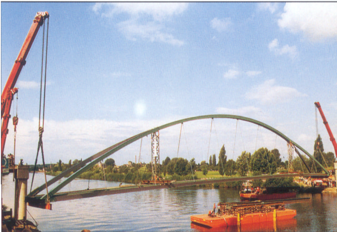
Esempio di sollevamento di un'arcata di ponte
